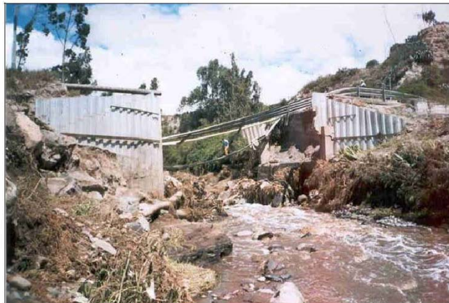
Photo 5 – Destruction du pont d'accès au lotissement La Pampa au nord de Quito Cliché : F. Demoraes – décembre 2001
