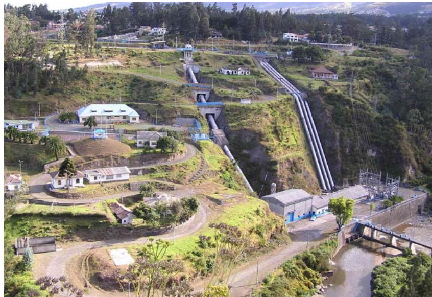
Photo 11 – Centrale hydraulique au bord de la rivière San Pedro . Guangopolo Cliché : T. Serrano juillet 2007
