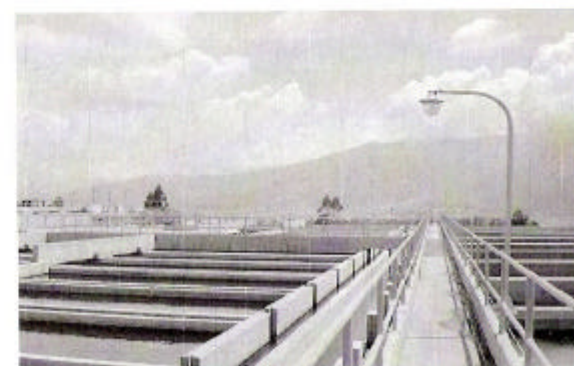
PLANTA DE TRATAMIENTO DE AGUA
