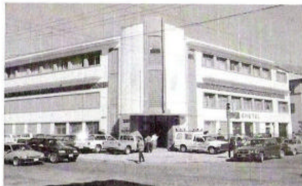
CENTRAL DE TELECOMUNICACIONES
