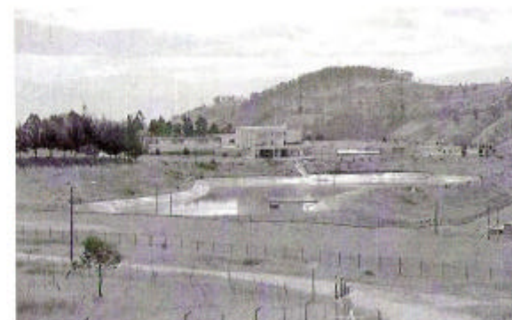
PLANTA DE TRATAMIENTO DE AGUA DE PUENGASI
