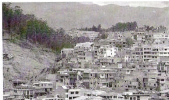
LADERAS SUSCEPTIBLES A DESLIZAMIENTOS
